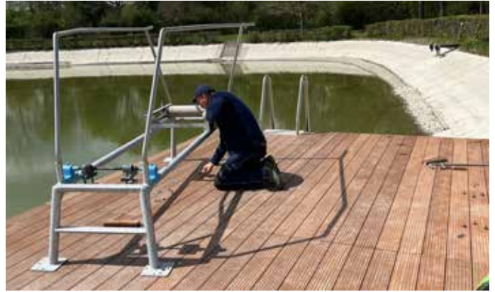
Sprungbrettanlage im Rohbau und fertig
