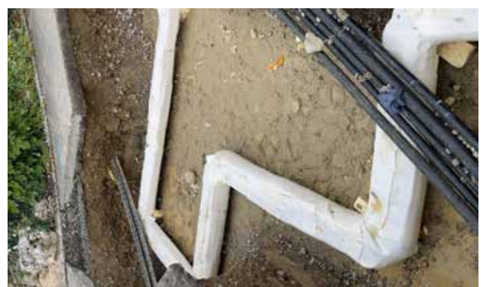
Leitungsverlegung Nahwärme bei neuer Heizzentrale und Burgstall
